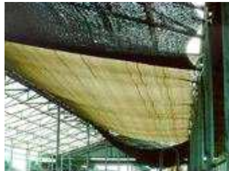
<축사지붕 및 축사내에 차광망 설치>
