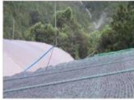
<축사 지붕 위로의 물 분사>
