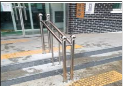
수직안전 손잡이 설치
