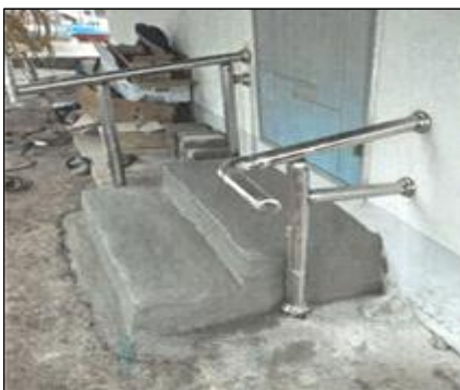
계단 및 안전손잡이 설치
